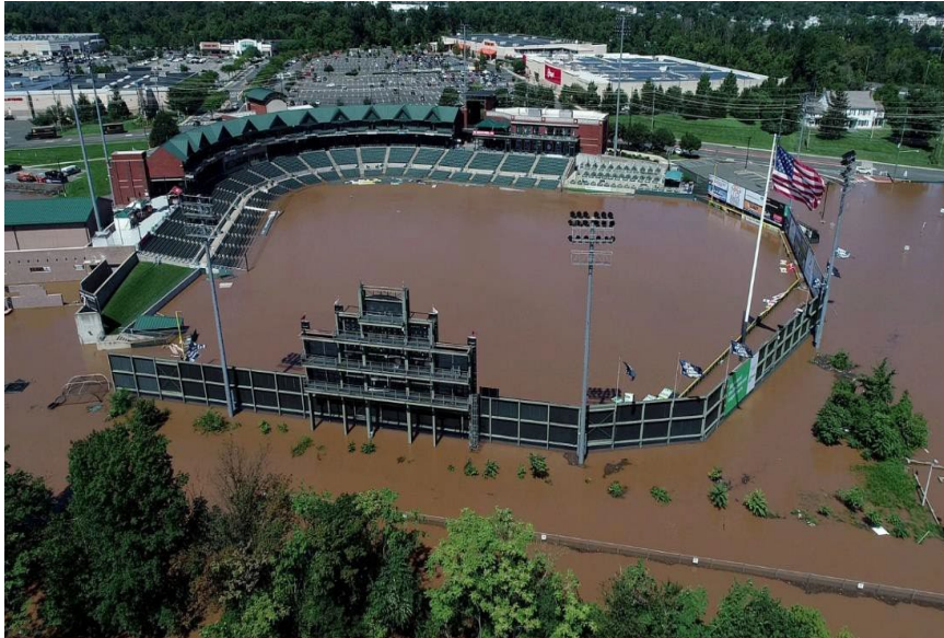
Fig. 18: Estadio de béisbol del TD Bank inundado por precipitaciones del huracán Ida
