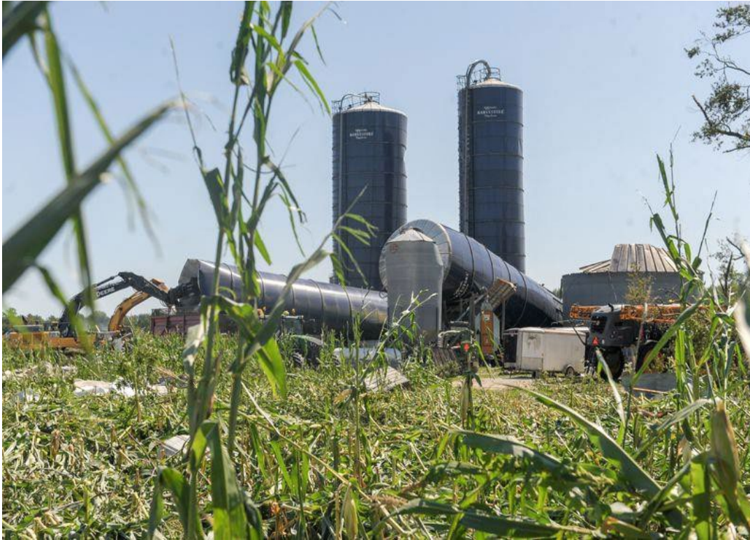
Fig. 20: Daños por tornado en Wellacrest Farms en Mullica Hill, Nueva Jersey, jueves 2 de septiembre de 2021.
